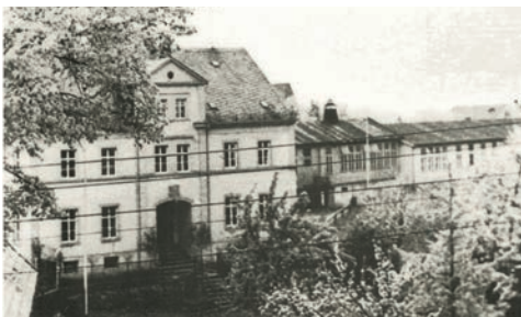
Schulgebäude und Schulbaracken 1926, Ansicht von Gornauer Straße
