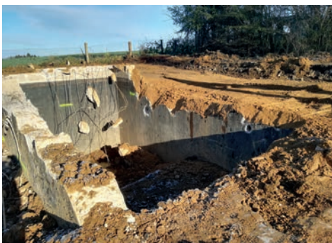
Reste des Behälters unter Pumpenhaus 2022
