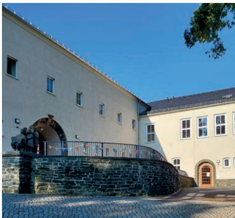
Schule nach der Sanierung, 2023
