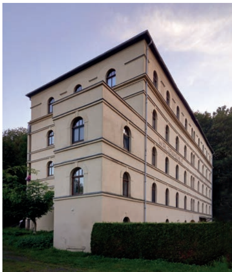
Ehemalige „Walzenmühle Ernst Stiefel“ in Erfenschlag. Das denkmalgeschützte Gebäude wurde in den 1990er Jahren privat saniert und zu Eigentumswohnungen umgebaut.
